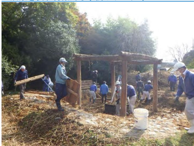
上久堅地区との協働による北田遺跡復元家屋解体作業
