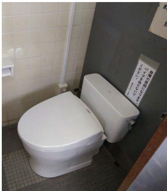
トイレ洋式化の写真 松尾総合運動場男子トイレ
