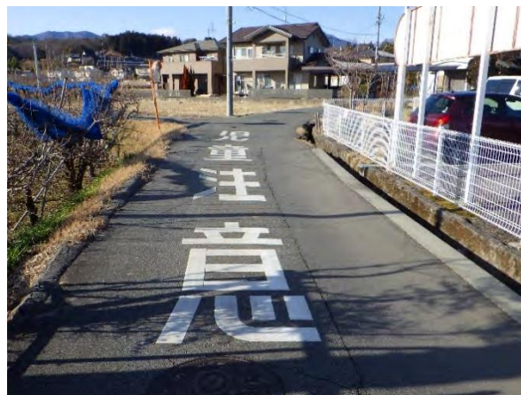
通学路における注意喚起のための路面標示を施工
