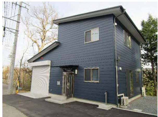
第11分団(川路)大明神班消防詰所
